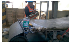
Empalme en frío
