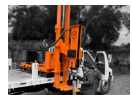
Instaladores de defensas metálicas
